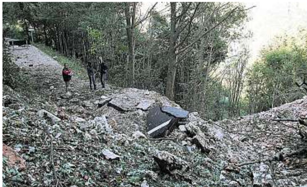
Quel che resta di strada Graziani tra Bocca Navene e Pra' Alpentina, la voragine fa pensare a un'esplosione
