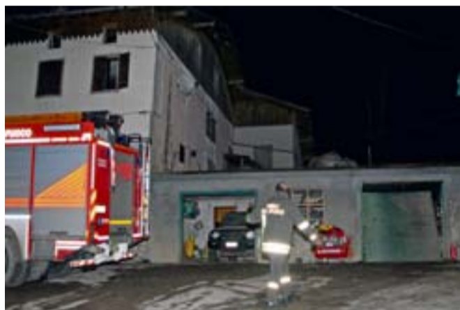
L'esterno del garage in cui è avvenuta la tragica esplosione
