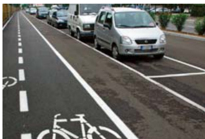
Viale della Scienza: è una delle strade coinvolte dai lavori
